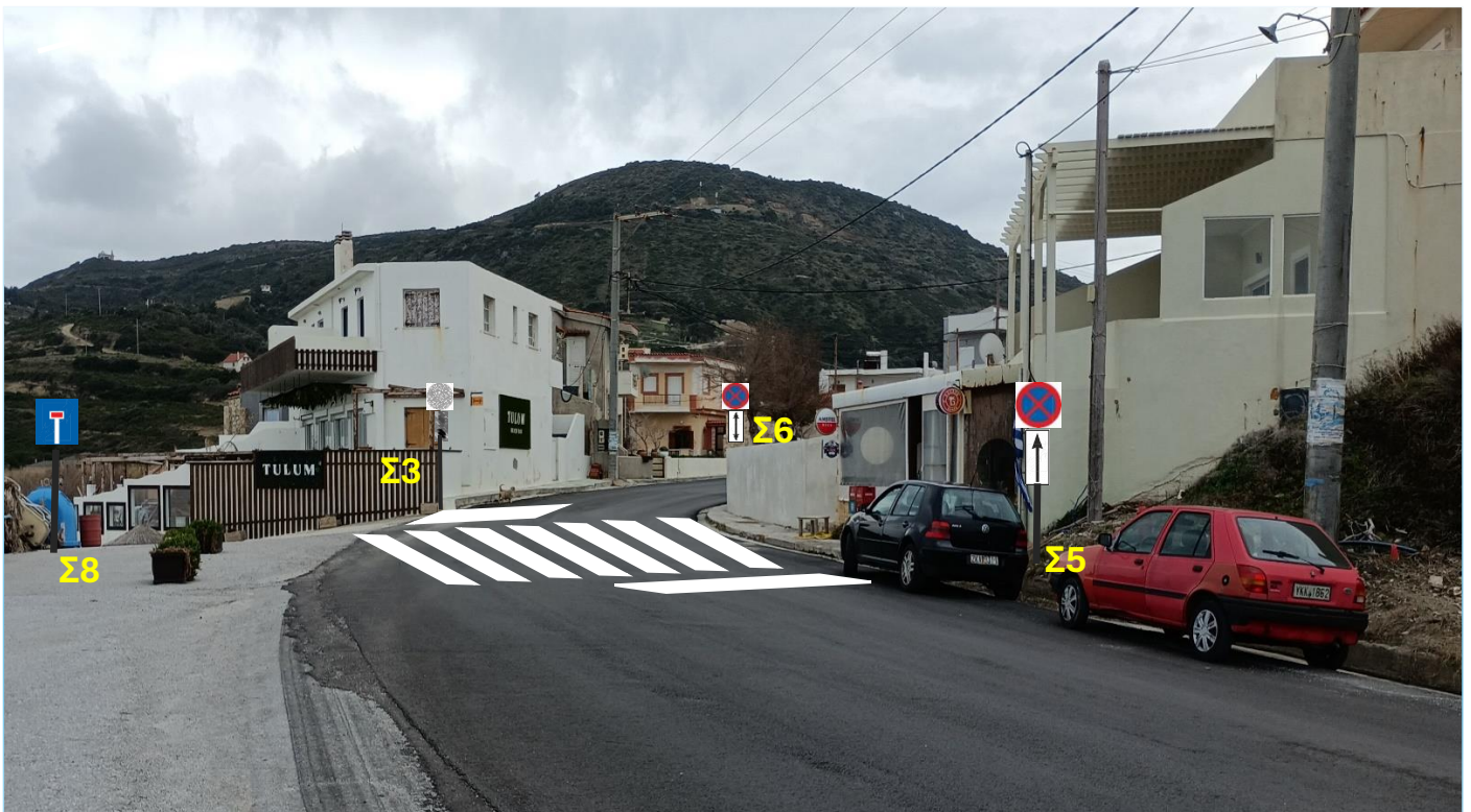
(Φωτ. 3) ΠΡΟΤΕΙΝΟΜΕΝΗ ΘΕΣΗ Σ5, Σ6, Σ3 (πίσω όψη), Σ8 και ΟΡΙΖΟΝΤΙΑ ΔΙΑΓΡΑΜΜΙΣΗ ΠΕΖΩΝ
